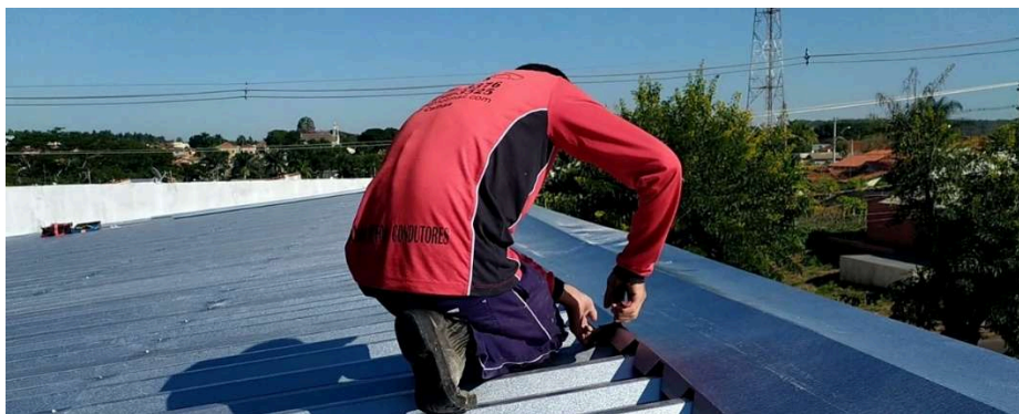
Recorte correto de rufo transversal à telha
