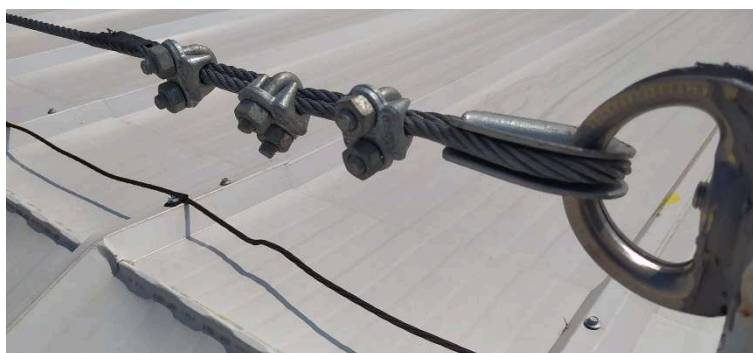
Detalhe de olhal, abraçadeiras, sapatilho e cabo de aço
